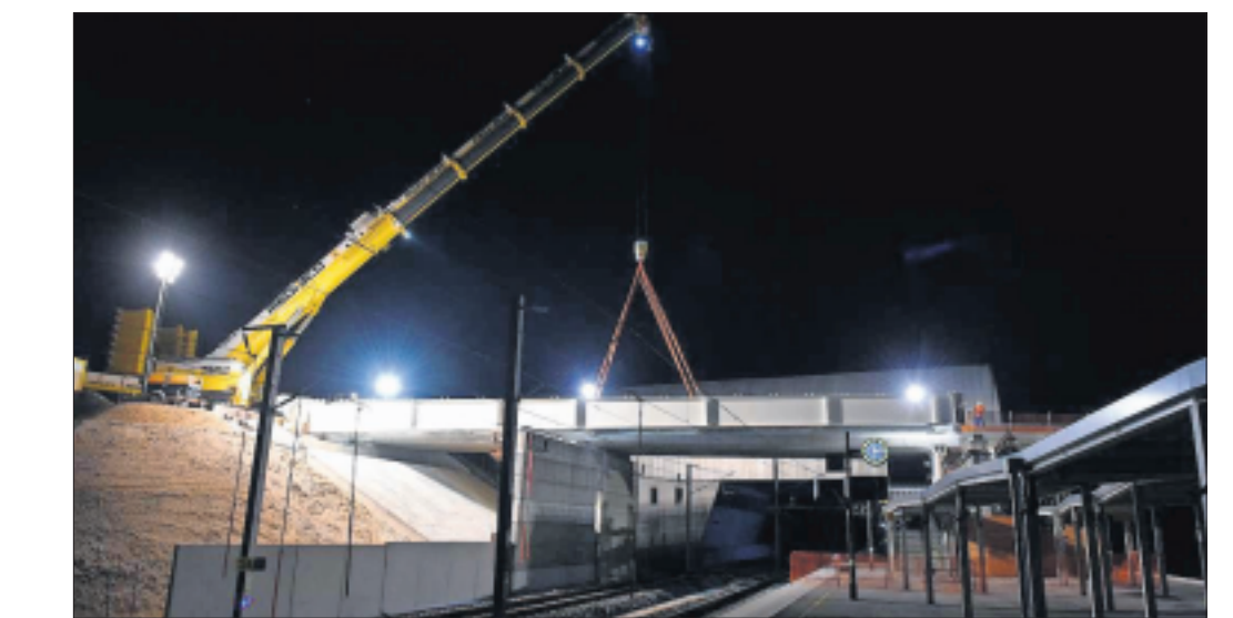
Installation du pont où circulera la future ligne Delle-Belfort, qui passera par-dessus les rails du TGV, en service depuis 2011.
